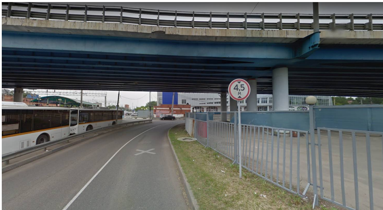
Рисунок 5 Маршрут испытаний, разворот под эстакадой
