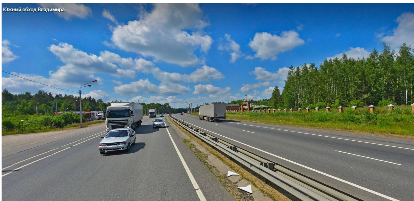
Рисунок 4 Маршрут испытаний, Южный обход Владимира
